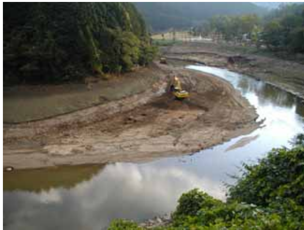
室生ダム堆砂除去状況
