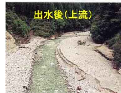
出水の流送土砂は、貯水池上流に堆積することなく、ほぼ全量がダム下流へバイパスされている。
