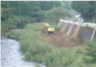
土砂置土整地状況
