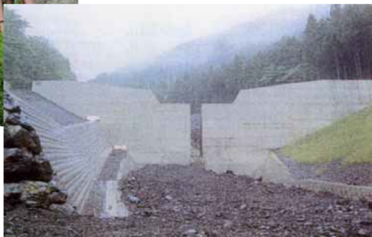
土砂の連続性が容易な施設例(透過型砂防えん堤)
