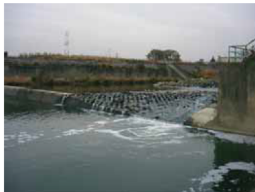
支川縦断方向不連続修復例 (淀川支川天野川)
