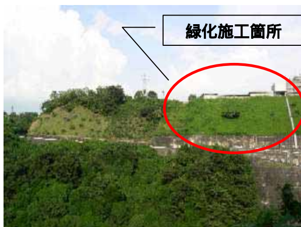
緑化された法面の状況
