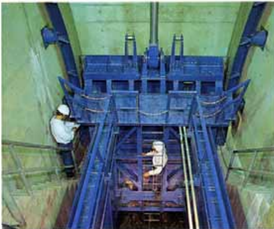
ゲートの点検状況
