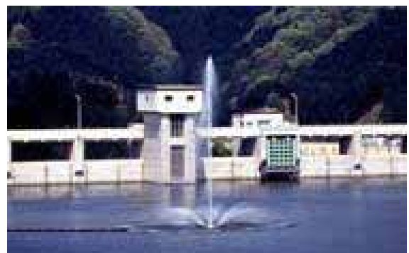
水質保全施設(布目ダム)
