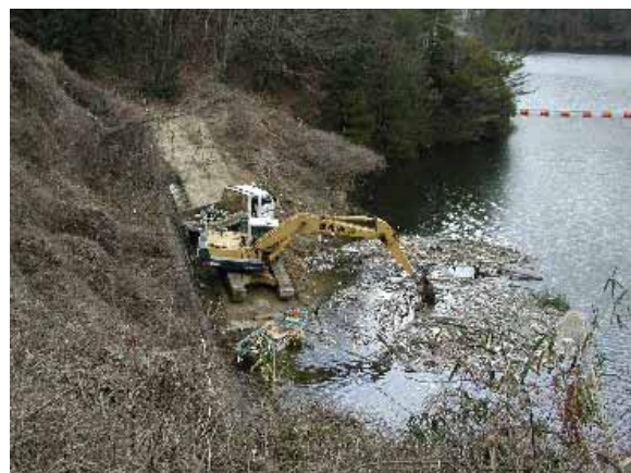
流木の引き上げ状況
