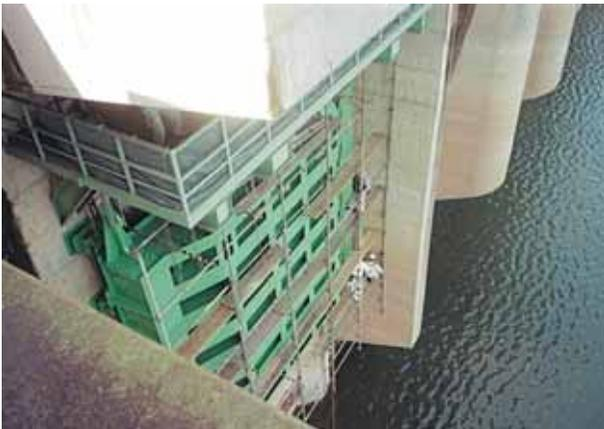
腐食防止のためのゲート塗装状況
