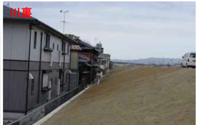
↑施工後(ドレーン工設置後の様子)
