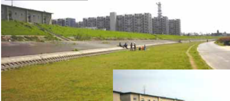
断面拡大:施工前
