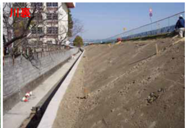
↑工事中(ドレーン工設置後の覆土の様子)
