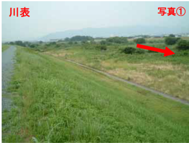
↑ 侵食対策箇所の様子(6.4K付近から上流を望む)
