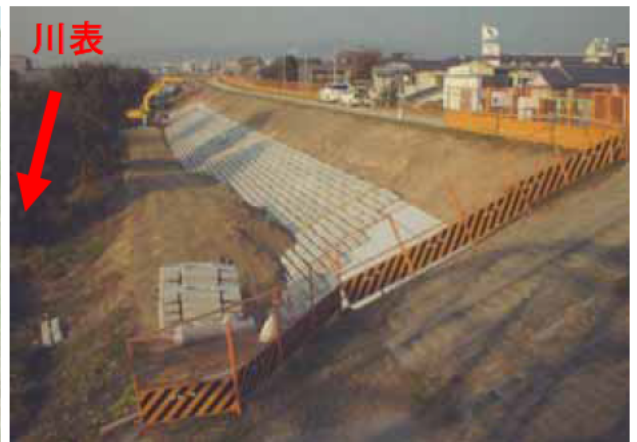
↑工事中(護岸工設置の様子)
