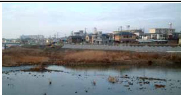
↑築堤工事の様子
