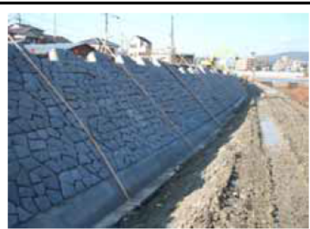
↑高水護岸工設置の様子
