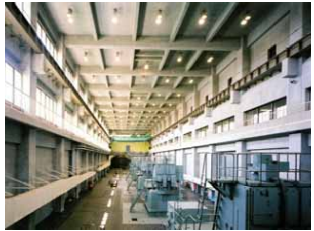
毛馬排水機場上屋(完了状況)
