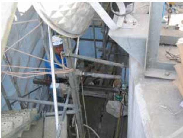
淀川大堰(PC鋼棒貫通用コア抜き状況)
