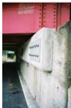
縁端拡幅の施工例
