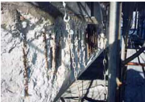
3号堰柱操作台の鉄筋腐食状況
