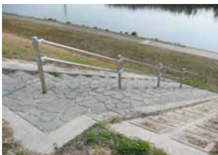
手すり付き階段
