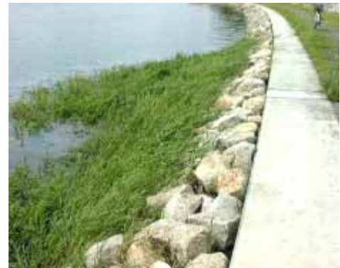
捨石設置状況
