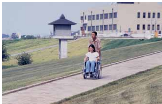
車椅子の通行に配慮した坂路の整備(淀川の事例)
