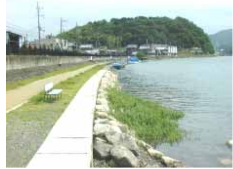
高水敷散策路整備状況
