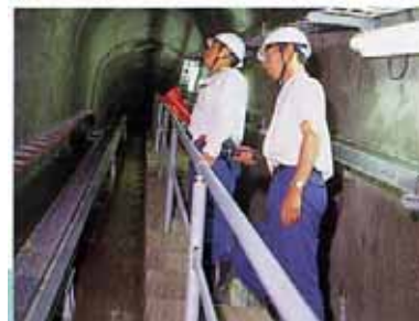
ダム本体の観測・点検状況
