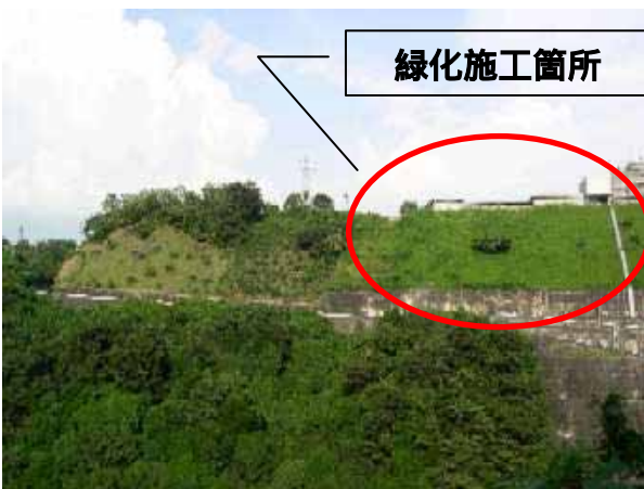
緑化された法面の状況
