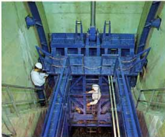
ゲートの点検状況
