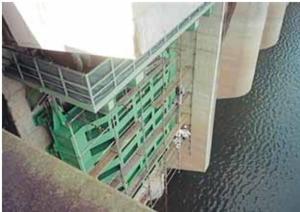
腐食防止のためのゲート塗装状況
