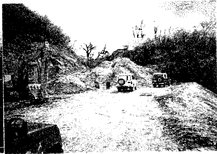
中腹より奥へ道路工事中
