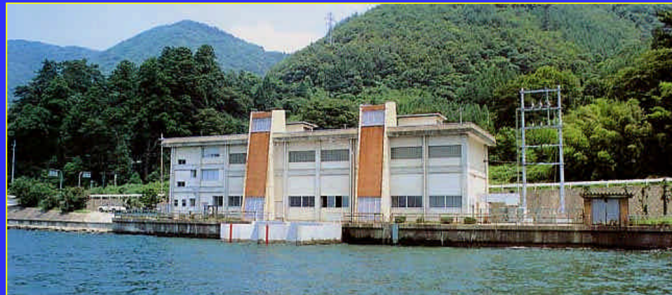
余呉湖補給 揚水機場
