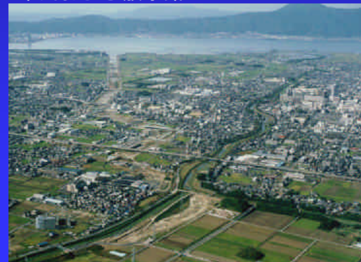
本川および放水路
