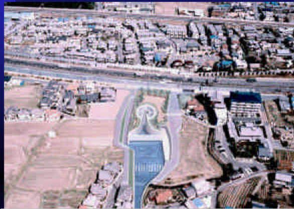
分水工（現河川から放水路へ導水する施設）のイメージパース
