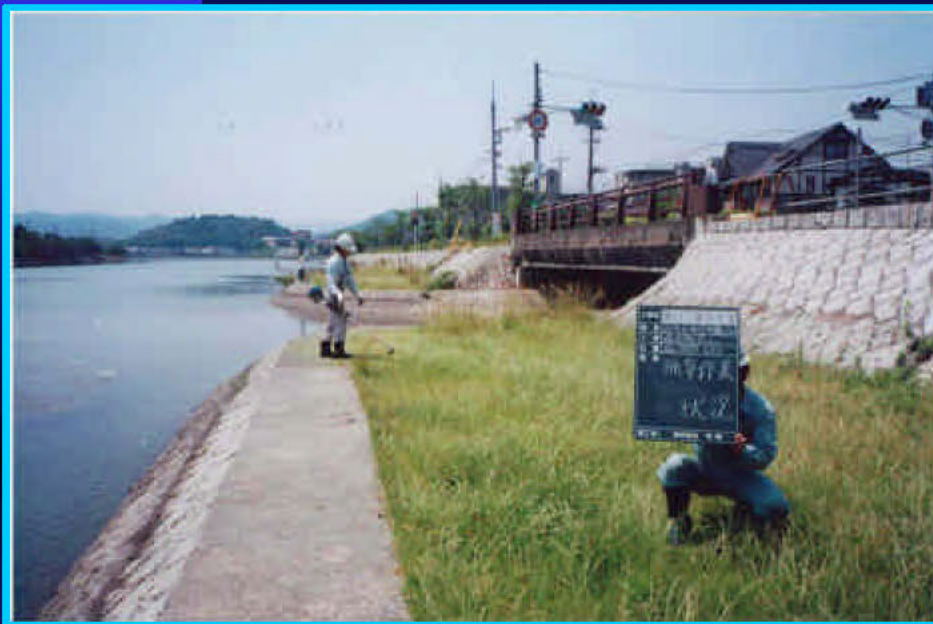
除草作業状況
