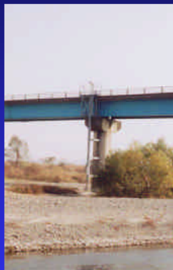
水質自動監視装置
