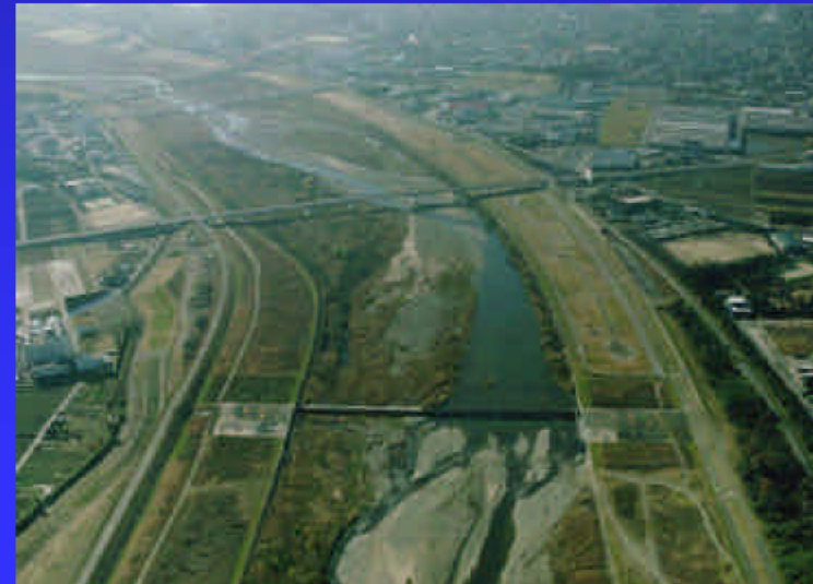
落差工上流部
