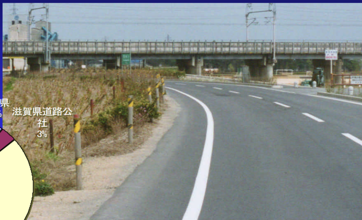
堤防天端利用による兼用道路
