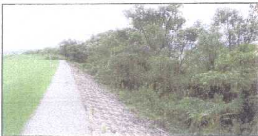
右岸8.5K付近 上流を望む JR琵琶湖線付近上流
