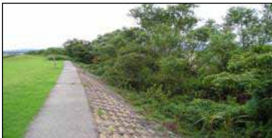
右岸8.5K付近 上流を望む JR琵琶湖線付近上流
