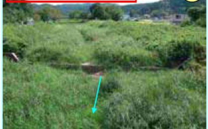
県管理区間(いおろ橋上流)
