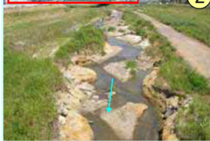
草津川大橋(R1)から上流
