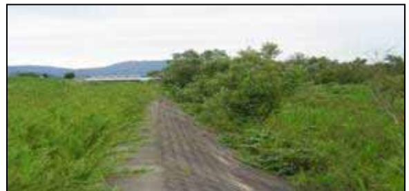
右岸8.0K付近 上流を望む 落差工上流1.0K付近
