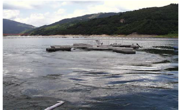
図 4.1.2 曝気装置概要図および曝気装置運転の様子（草木ダム）
