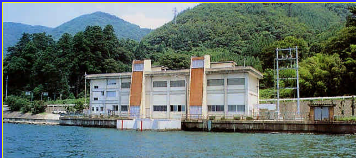
余呉湖補給 揚水機場
