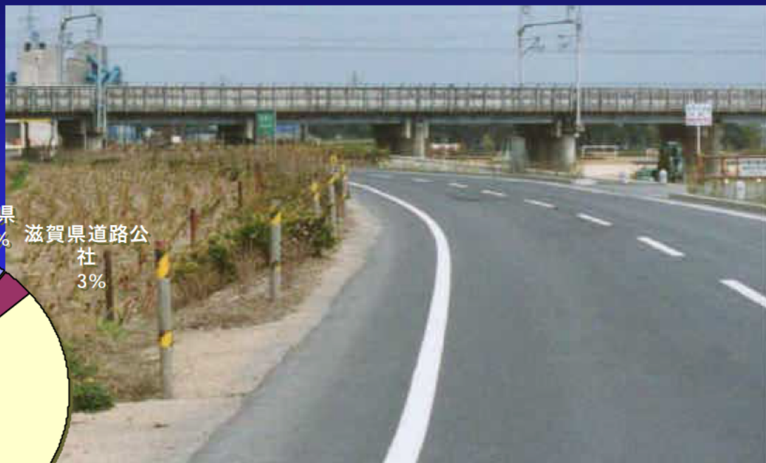
堤防天端利用による兼用道路
