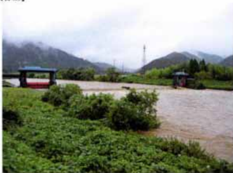
【高時川頭首工】
