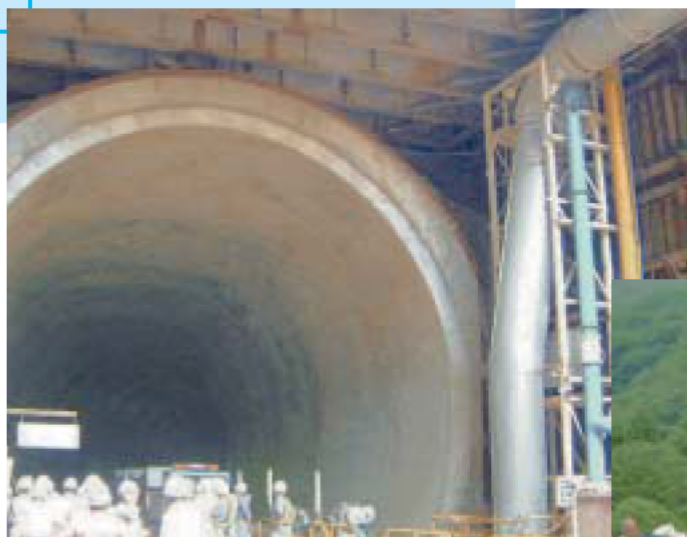
【 大津放水路工事現場にて】
