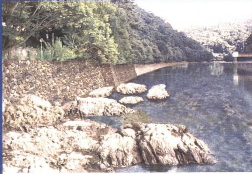
亀石部 0.8m掘削 平水位(約40m 3 /s)
