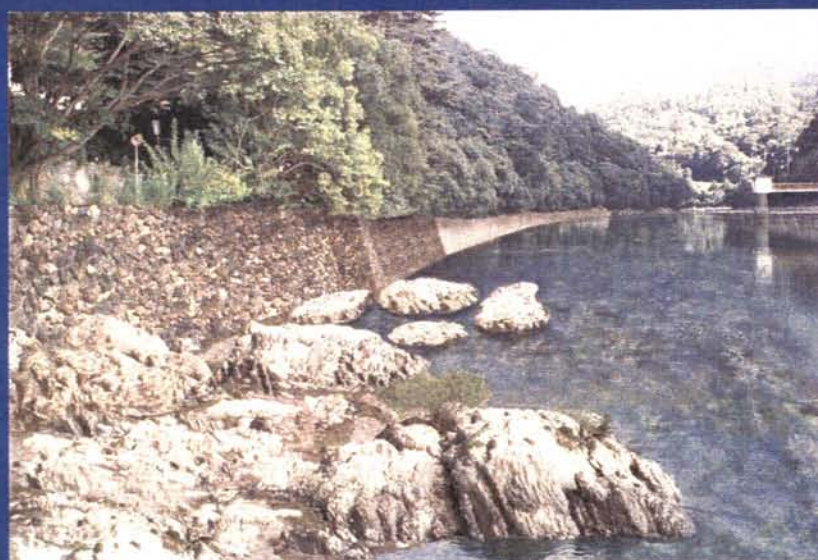
亀石部 1.1m掘削 平水位(約40m 3 /s)
