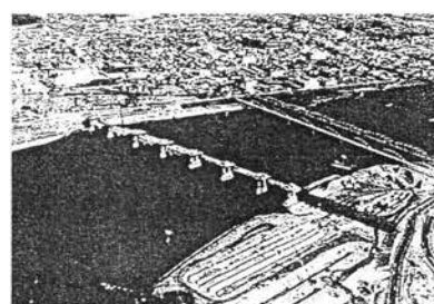
紀の川大堰(建設中)
