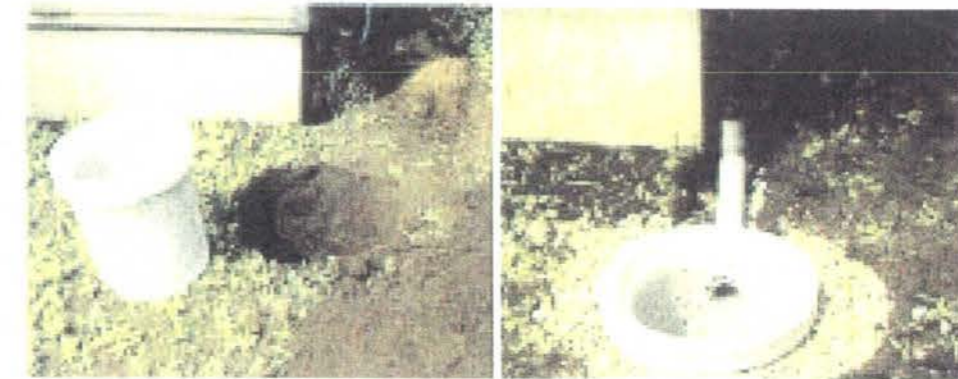
写真-1.10 雨水浸透マスの施工例 (国土交通省ウェブ・ページより)
