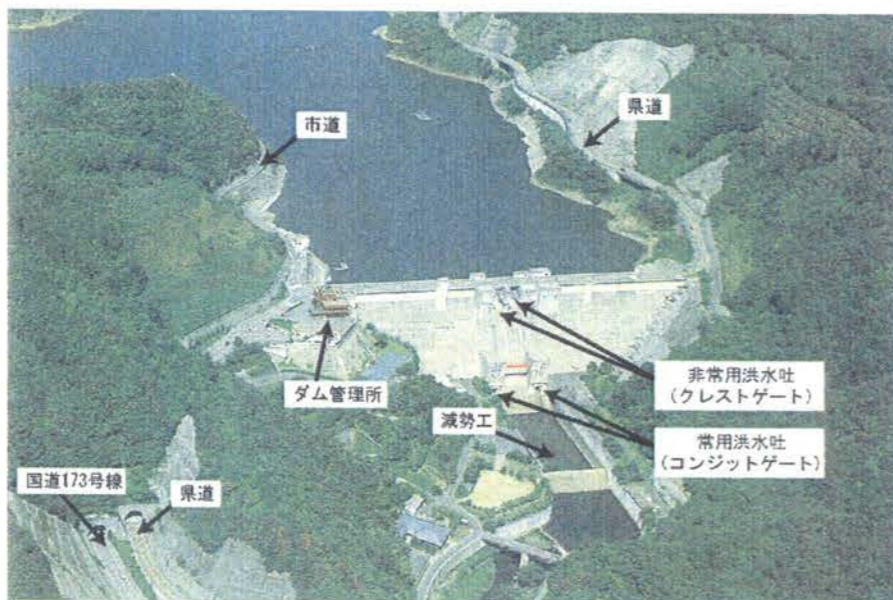
図-1 一庫ダム管理施設と周辺道路
