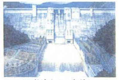
放流中の一庫ダム
