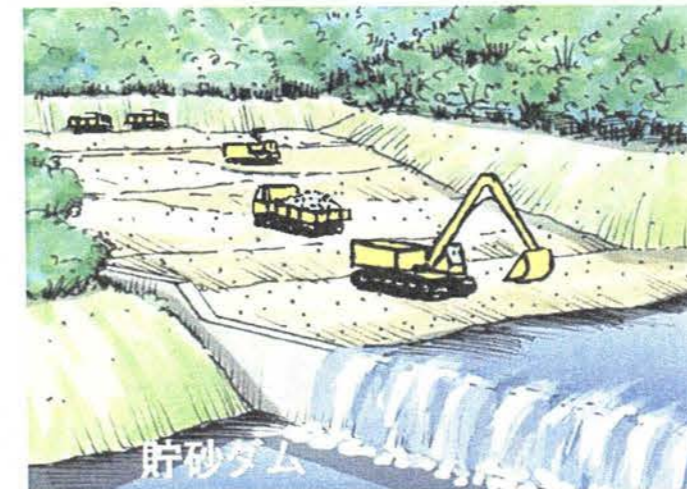
図-1.16 貯砂ダム堆積土砂の掘削状況例
