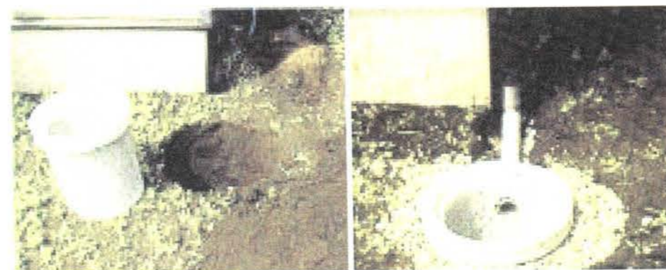
写真-1.10 雨水浸透マスの施工例 (国土交通省ウェブ・ページより)
