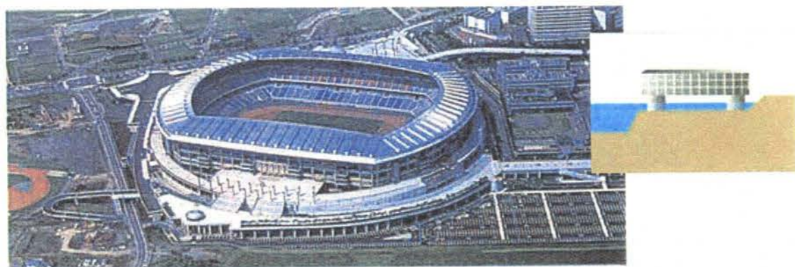
写真-1.6 高床式建築の例（横浜国際総合競技場）
