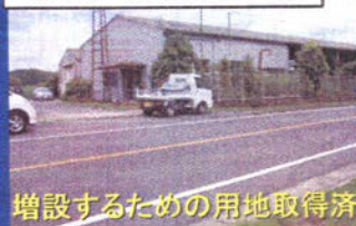
伊賀 飲料水工場
