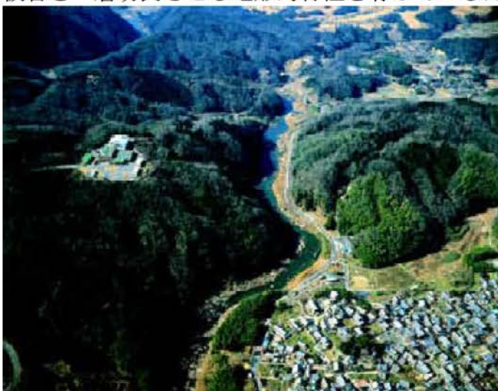
木津川本川上流から岩倉峡下流を望む
