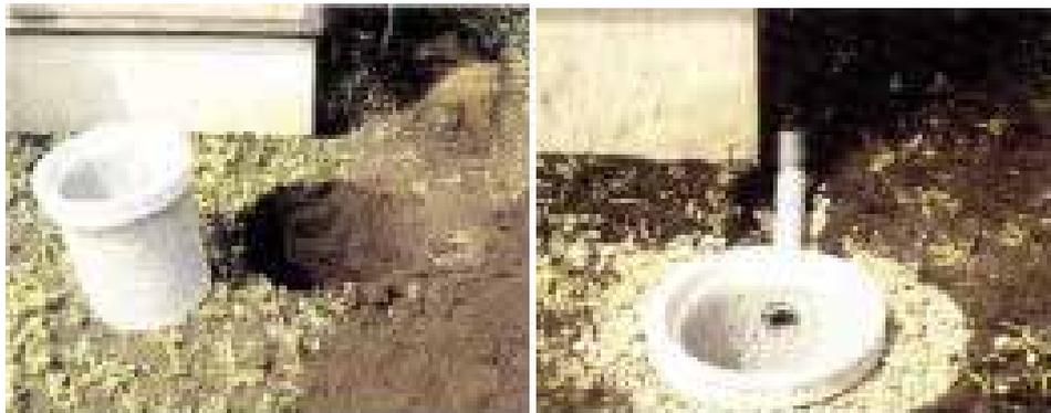
写真-1.10 雨水浸透マスの施工例
