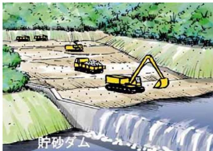
図-1.16 貯砂ダム堆積土砂の掘削状況例
