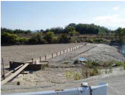
写真 H15.10.30、びわヤナ、 瀬切れ発生より遡上阻害発生
