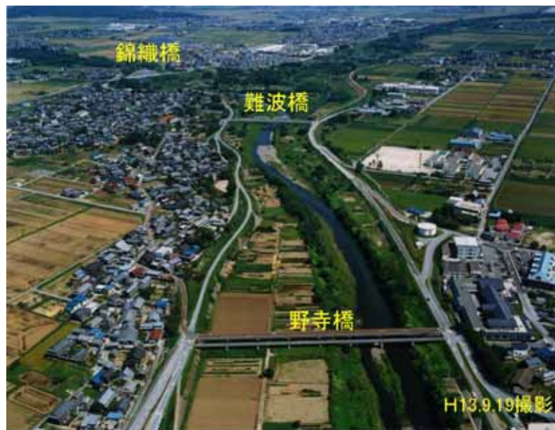
図-10 堤外民地の状況(野寺橋付近航空写真)
