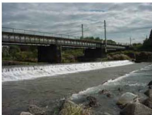
写真⑨ H15. 11. 12、 JR北陸本線直下の床止め工、河川流量減少より床固め工の遡上が容易でない状況。なお、この落差工の両端の魚道では、ジャンプでとび越えていった親魚もいた。(目視確認)
