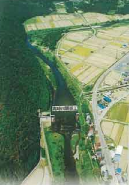
▲高時川開削工 井明神橋付近には、下流の村々の井塚が8つ集中して見られます。昭和17年（1942年）に、それらを一つにまとめた合同井塚が完成し、現在の高時川開削工は昭和43年（1968年）に完成しました。
