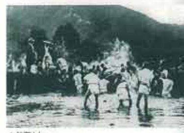
▲井落とし 「井落とし」は餅落とし、綾落とし、茶落としと、必要な時に行う時落としがあり、また用具を一切用いず、総て素手で井を引き抜き水を下流に流しました。
