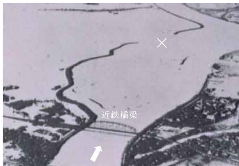
写真 2.2 宇治川の破堤
