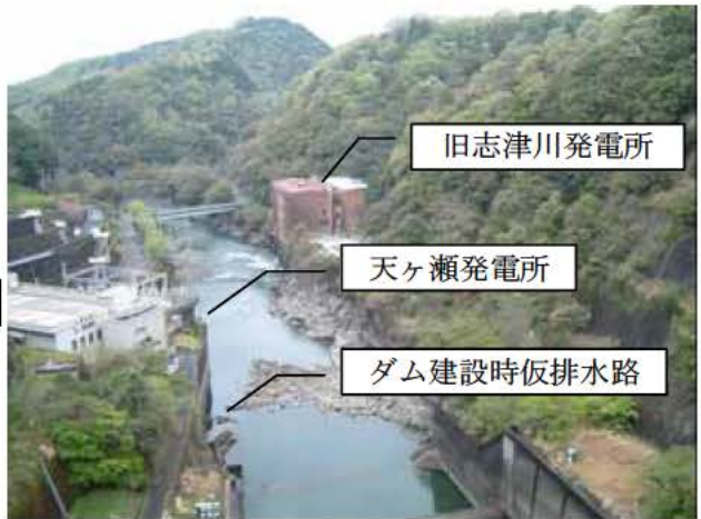
写真 3.7 天ヶ瀬ダムから下流を望む ダム放流 0\text{m}^3/\text{S} 、発電 30\text{m}^3/\text{S}
