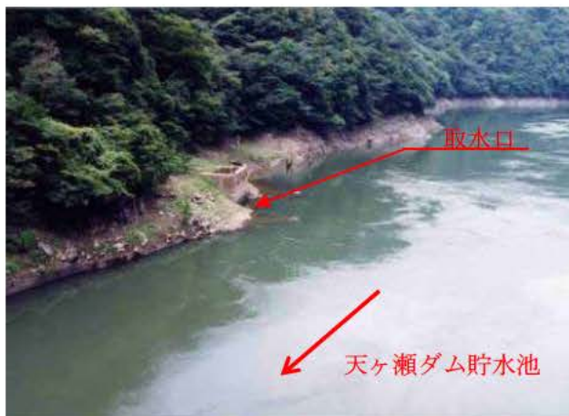
写真 3.10 旧志津川発電所取水口 (貯水位 O. P. +71m 付近)
