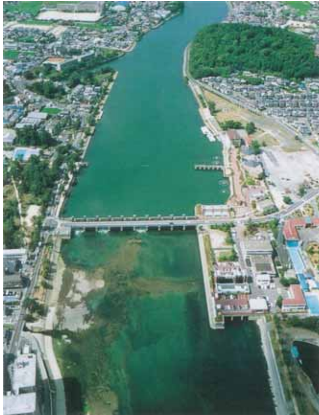
写真 1.4 瀬田川洗堰全景
