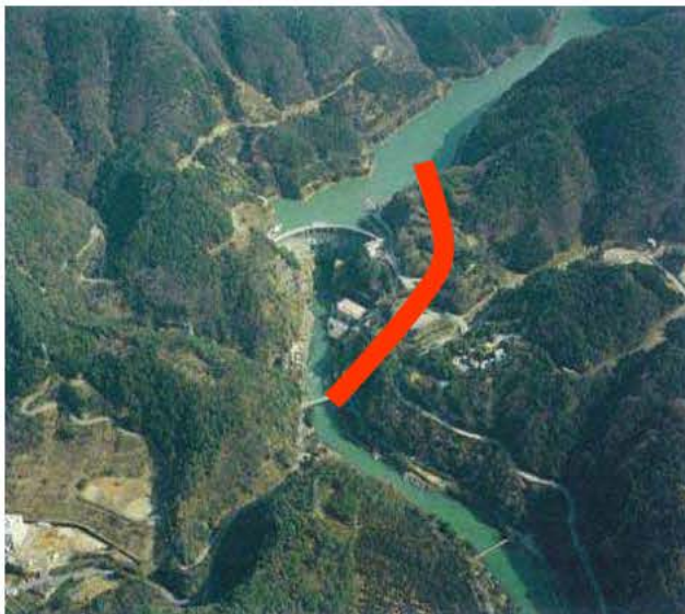
写真 3.12 左岸トンネル式放流設備ルート
