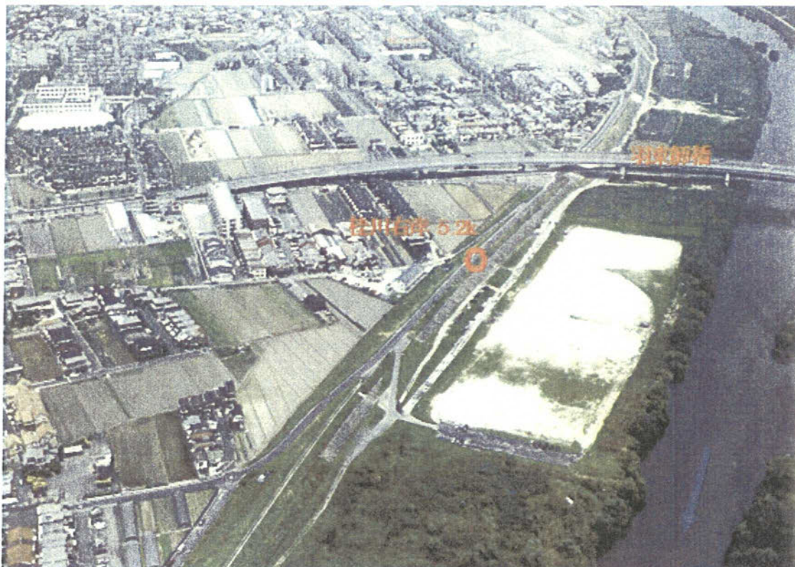
桂川右岸 5.2k 付近の状況
