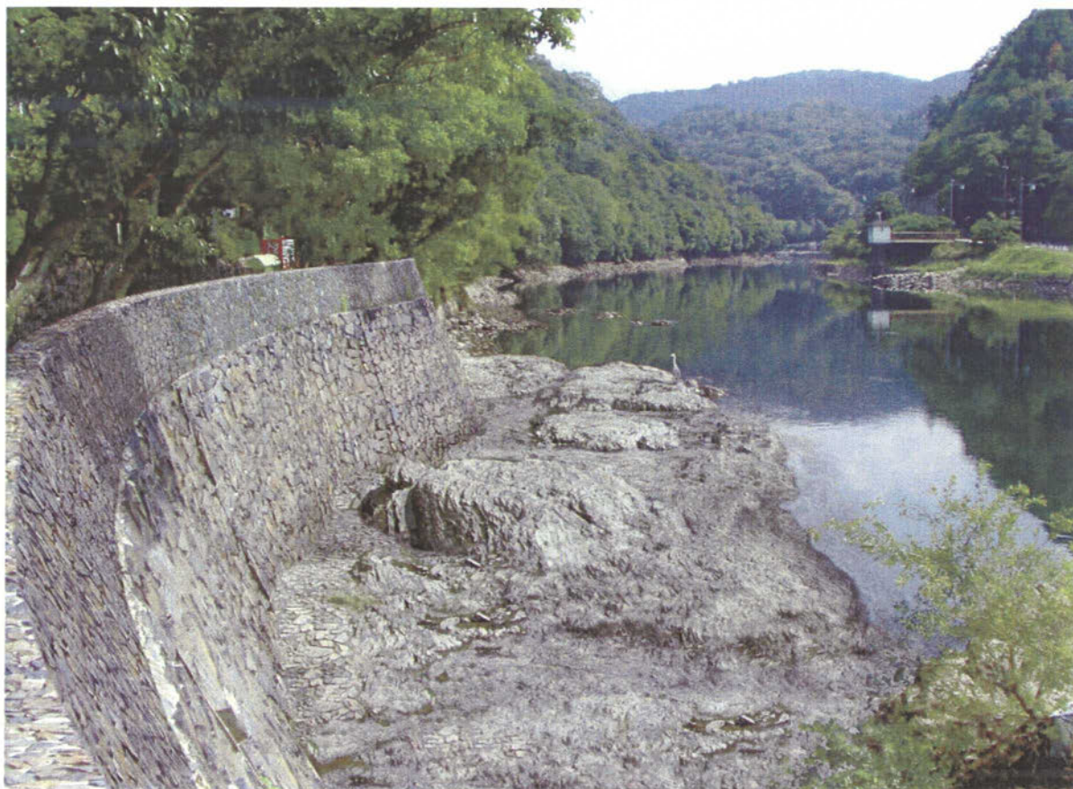
フォトモンタージュ [0.8m河道掘削時]
