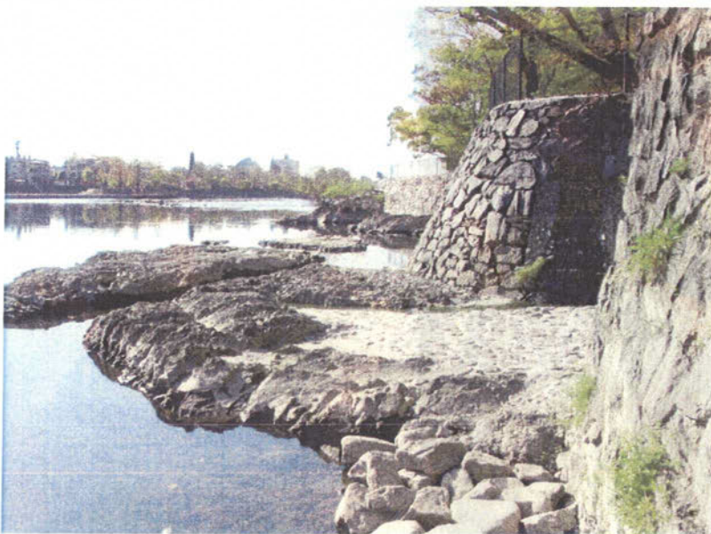
護岸工事後の亀石周辺 コンクリートで固められた
