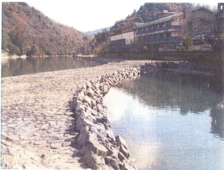
締切堤 建設費用2億円
