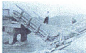
国友橋橋脚が沈下した様子 出典: 私とあなたの琵琶湖アルバム
