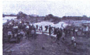
大正10年洪水による堤防復旧工事(高月町雨森)
