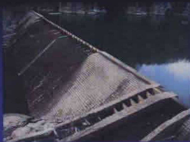
大河原堰堤(発電)
