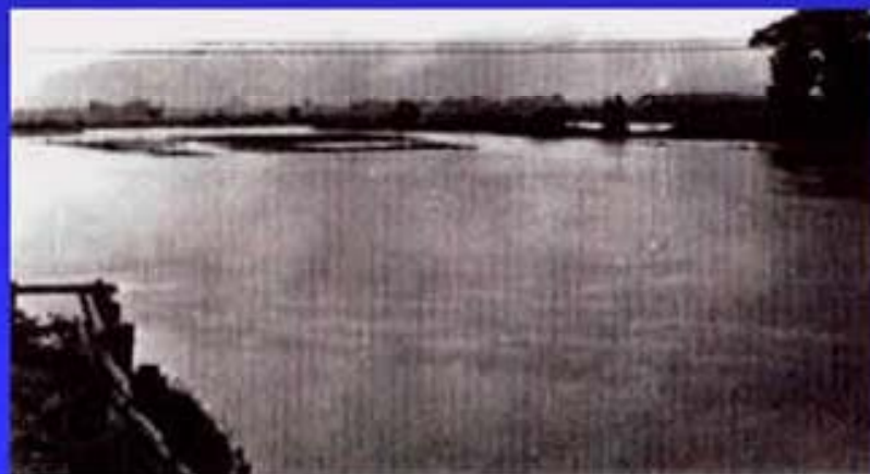
伊丹市下河原地内 猪名川支流内川付近の浸水状況
