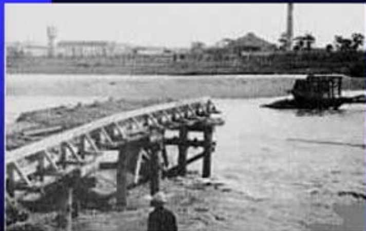
伊丹市桑津橋の流失状況
