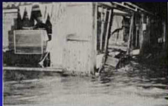
民家の被害状況(中の島)
