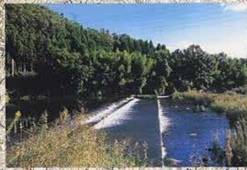
②湯頭首工
