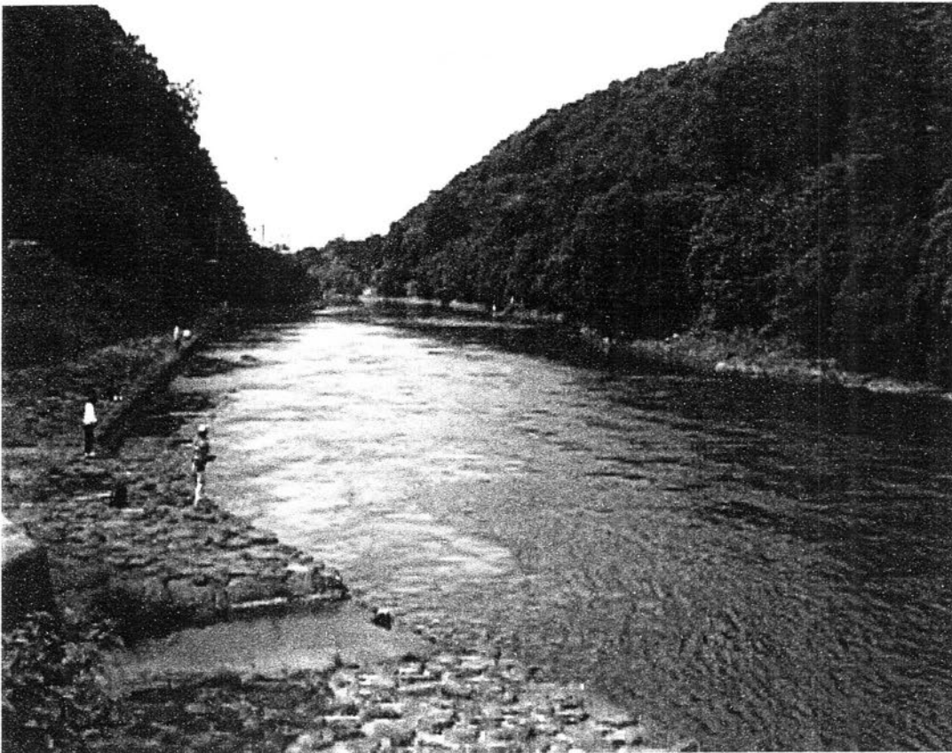
白川浜周辺、導水管敷設で左岸は石とコンクリートで固められた。左岸と東岸の対比。
