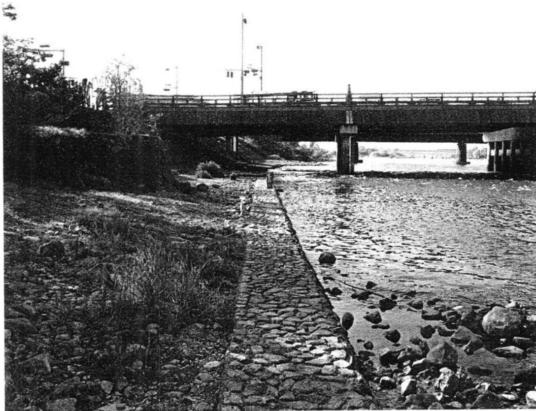
宇治川を埋め立てた塔の川床止め工事場所から宇治橋を見る
