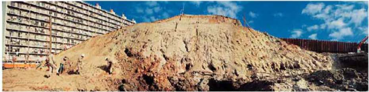
工事で開削された堤防断面。土砂だけで積み上げられていたのがよくわかる
