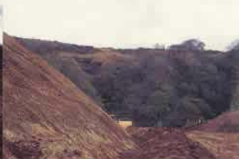
奥の方へ行く道路工事 これよりは歩いて無理
