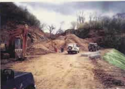
32 中腹より奥へ道路工事中
