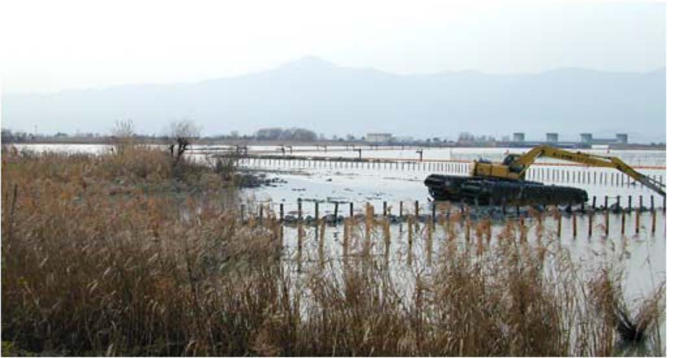
津田江の東北部の造成工事中。情緒のあった水辺が直線化される光景
